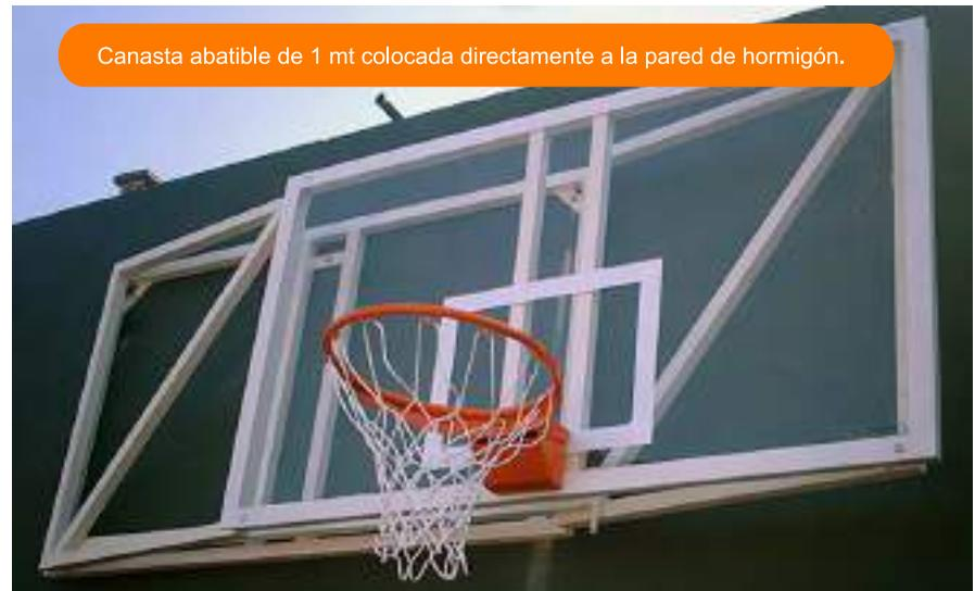
Canasta abatible de 1 mt colocada directamente a la pared de hormigón.
