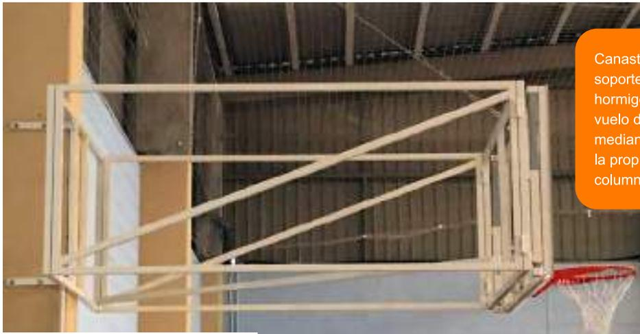
Canasta abatible de 2,50 mts colocada en columna mediante soportes metálicos a medida que se atornillan al propio hormigón de la columna, a su vez, debido al ser de mayor vuelo de 1,50 mts se le colocan unos tirantes superiores mediante cableado para dar más estabilidad y seguridad a la propia canasta. Tanto el cableado, como la estructura a la columna se presupuesta aparte.
